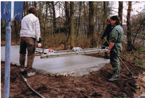
De grondplaat wordt gereed gemaakt
